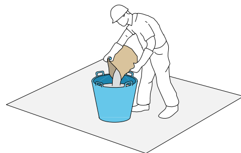
2) Vertido del pegamento de base cementosa.
